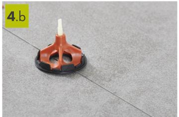
Installare la seconda base SOS; per farlo ripetere le operazioni da 1 a 5, avendo l'accortezza di mantenere tra le due ghiere un distanza compresa tra 1 e 3 cm.
