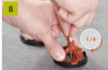
A questo punto il corretto tensionamento è stato raggiunto e di conseguenza il livellamento delle piastrelle. In caso il livellamento delle piastrelle non fosse soddisfacente, si consiglia di aggiungere ulteriori basi SOS e di aumentare il tensionamento delle basi avvitando ulteriormente le ghiere.
