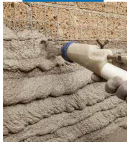
Applicazione di **MapeWall Intonaca & Rinforza** con intonacatrice
