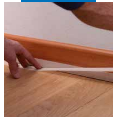
Preparazione protettiva per la sigillatura del giunto
