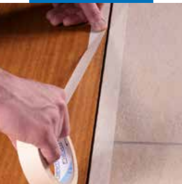
Preparazione protettiva per la sigillatura del giunto
