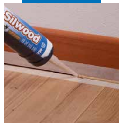
Riempimento del giunto
