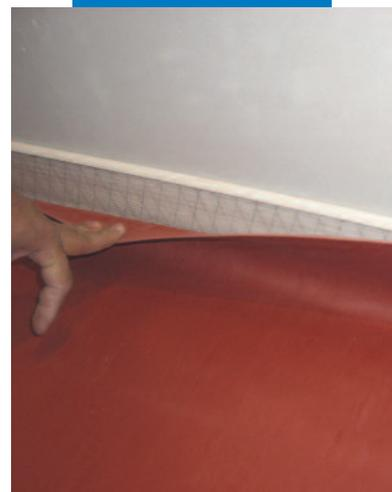
Realizzazione di sguscia mediante utilizzo di Mapecontact
